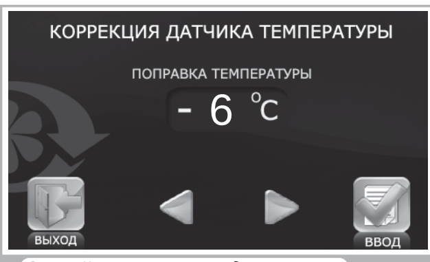
Рис. 28. Коррекция настроек датчика температуры
